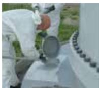
10. … 再涂覆一层额外的Triflex Towersafe风能专用防水涂料作为耐磨层。
