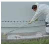
4. 在混凝土基座上涂覆Triflex Towersafe底涂。
