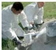
6. 所有节点和立面先做好防水：涂覆一层足量的Triflex Towersafe风能专用防水涂料，铺上德力封特制无纺布，去除任何气泡…
