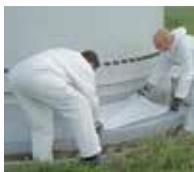
9. 同样按照两涂(Triflex Towersafe风能专用防水)一布(德力封特制无纺布)进行防水…
