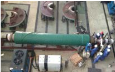
电厂汽轮机转子修复现场
