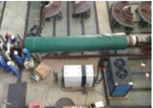
现场紧急抢修
