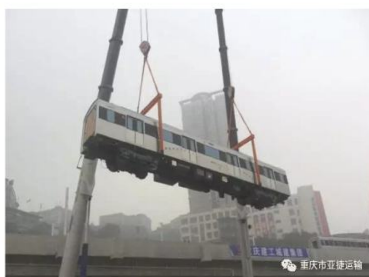
重庆轨道交通PC梁、车厢吊装 及运输、钢轨、道岔等物资运输
