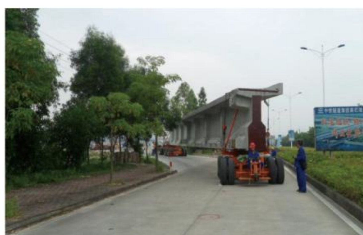
广珠铁路T型梁运输
