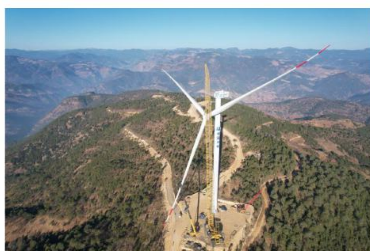
广西百色项目叶片吊装
