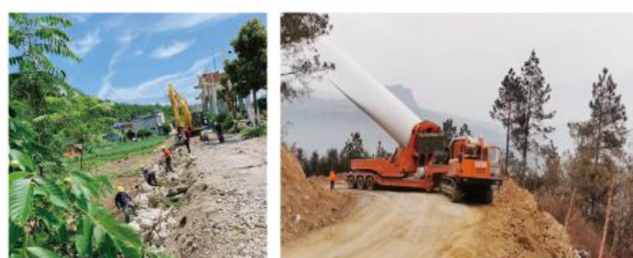
重庆红椿土建施工 重庆南川风吹村叶片履带车运输
