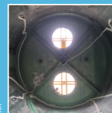
叶根载荷安装
