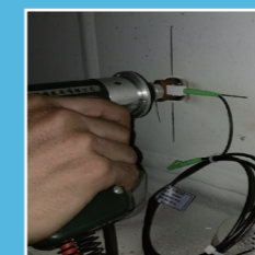
塔筒应变 传感器安装
