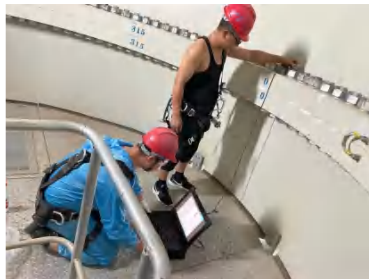
塔筒螺栓探伤
