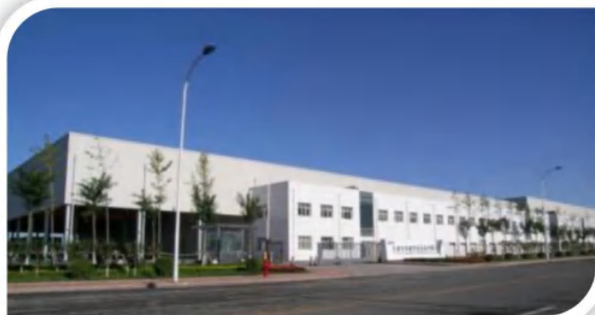
天津-维修基地1
