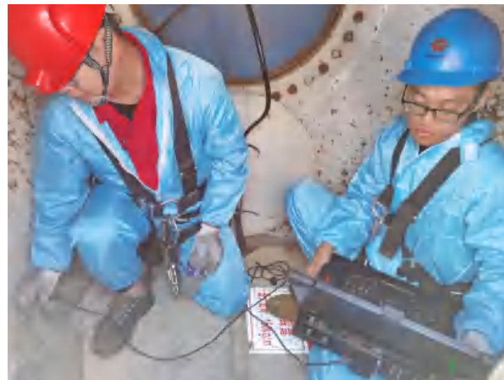
叶根螺栓探伤
