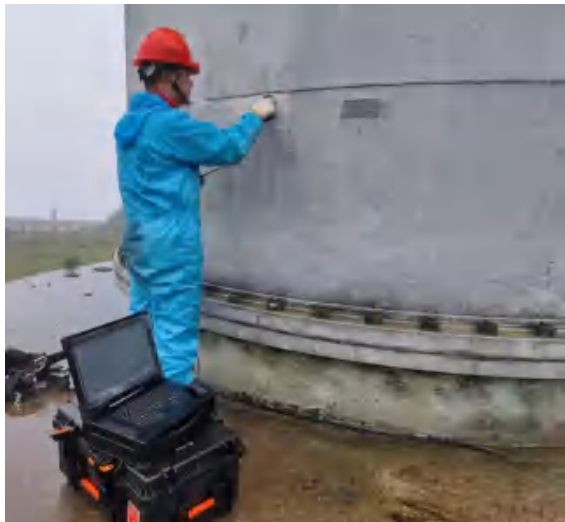
塔筒焊缝探伤
