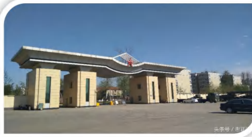
河北-维修基地2
