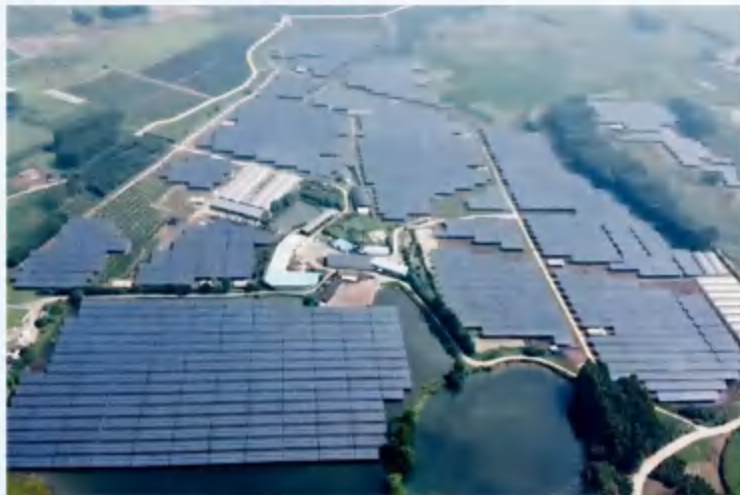
浙江浮式电站50MW
