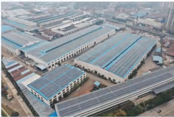
苏州工商业电站10MWP
