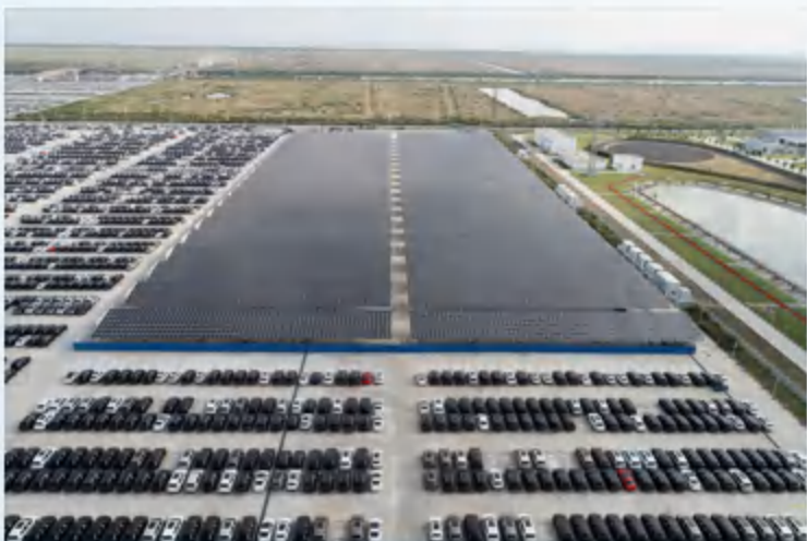
上海大众停车场项目17MWP
