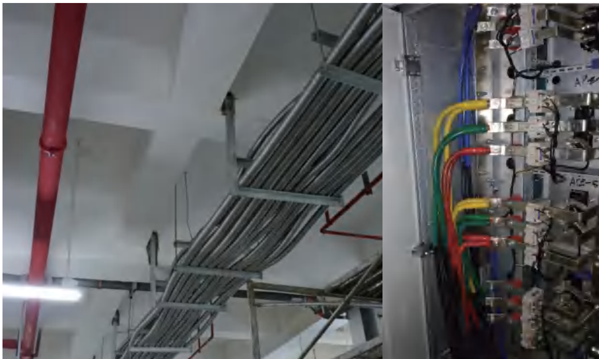
重庆佳华世纪新城E区盒马鲜生超市配电工程项目
