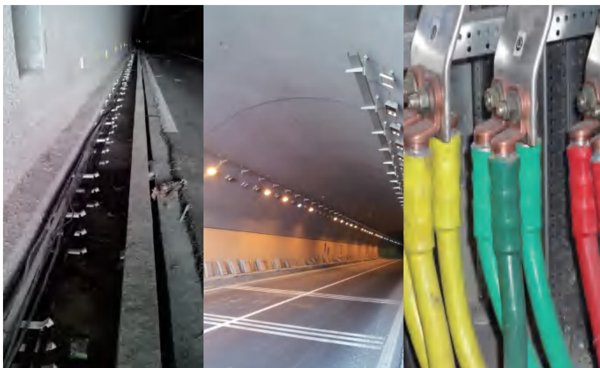
贵州余凯高速项目
