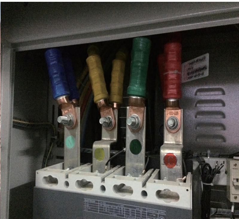
株洲联诚厂房项目
