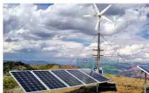
四川山区某风电场
