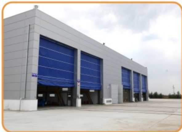
风电塔筒涂装生产线
