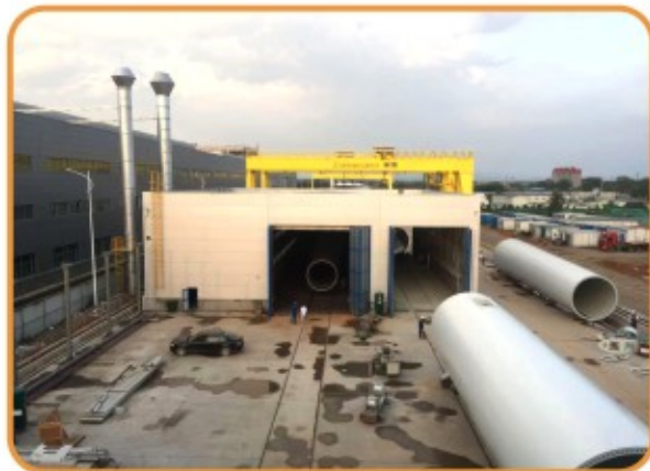
风电塔筒涂装生产线
