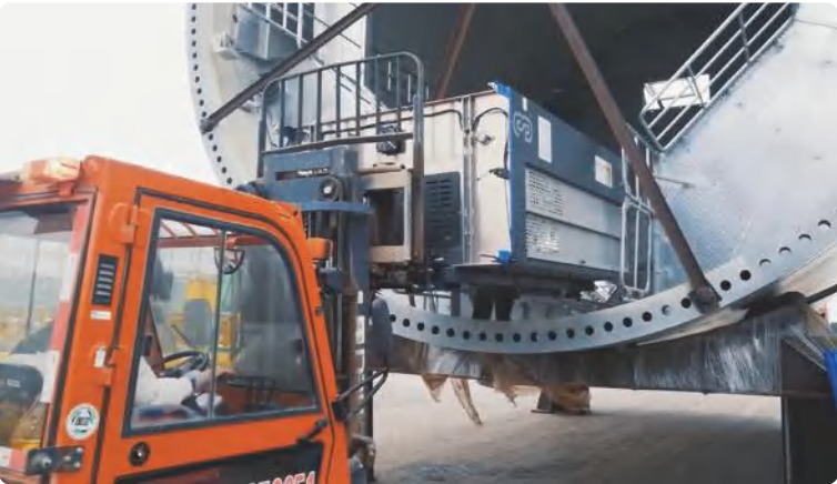
塔筒厂预安装现场图
